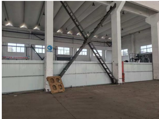
移动式集装箱/货物/车辆检查系统调试区西侧（江苏利卡维智能科技有限公司）
