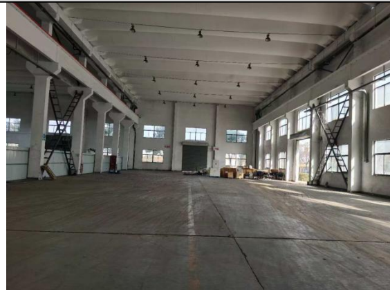
移动式集装箱/货物/车辆检查系统调试区北侧 (同核科技(江苏)有限公司)
