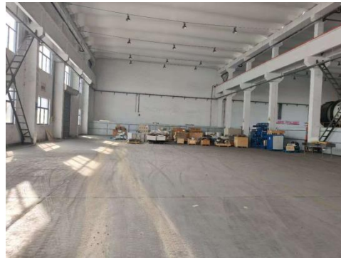
移动式集装箱/货物/车辆检查系统调试区拟建址现状
