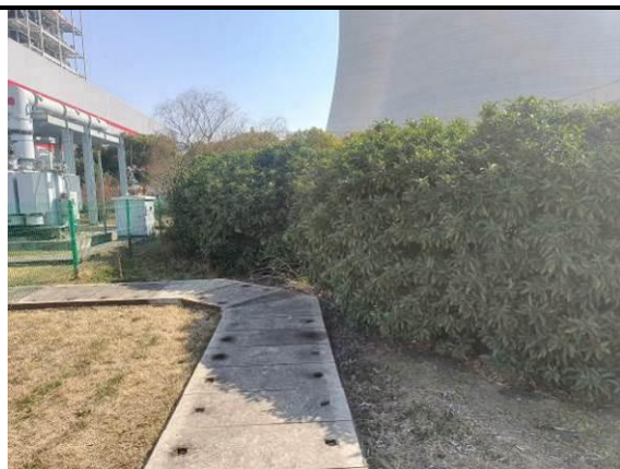
图 3-4 升压站周围绿化恢复
