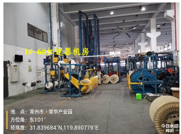
图 8-2 本项目电子加速器辐照装置项目拟建址东侧（现有加速器工作场所）
