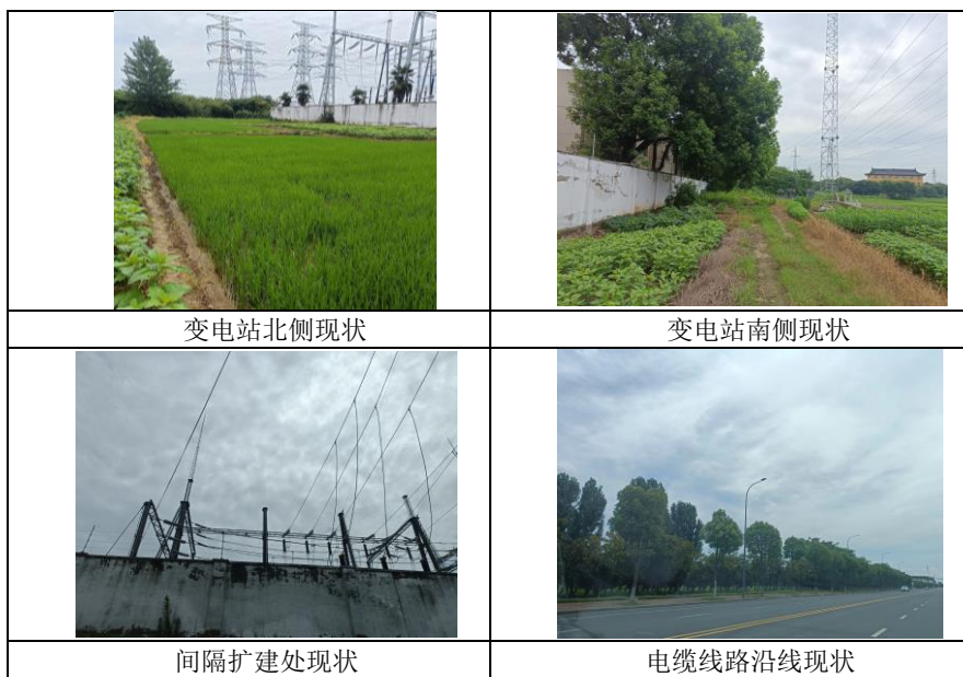
图 3-1 本项目站址、拟扩建处和线路沿线环境现状照片
