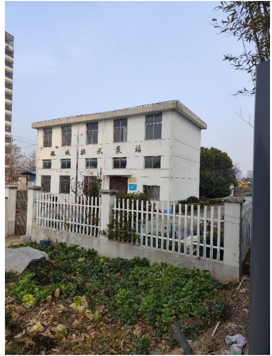
拟建址西南侧（潞城换水泵站）
