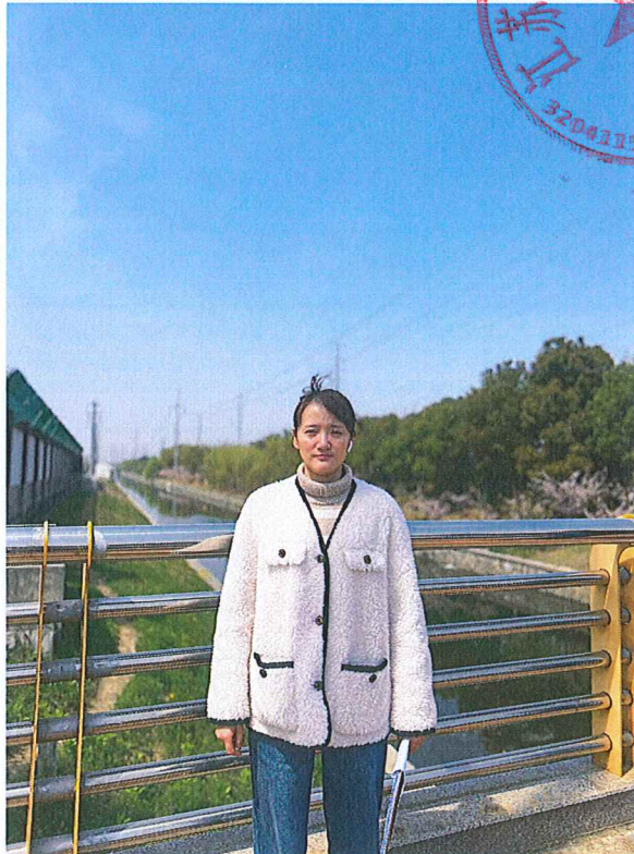
图 2 环评工程师现场照片（进线 T 接中瑞电子 110kV 进线）
