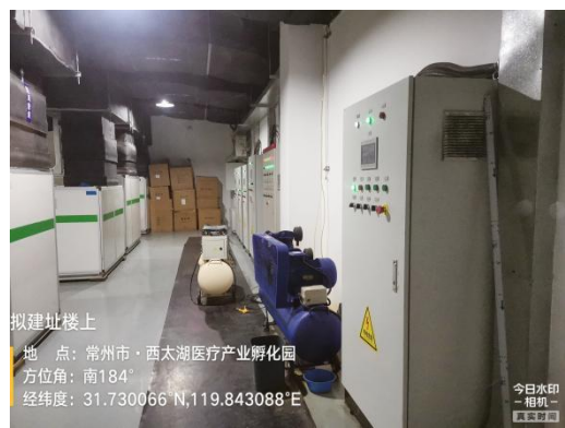
图 8-6 介入手术室拟建址上方（空调设备间）
