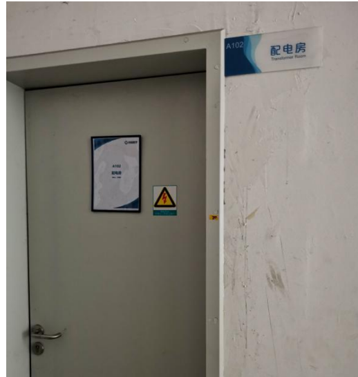
图 8-4 介入手术室拟建址西侧（配电房）
