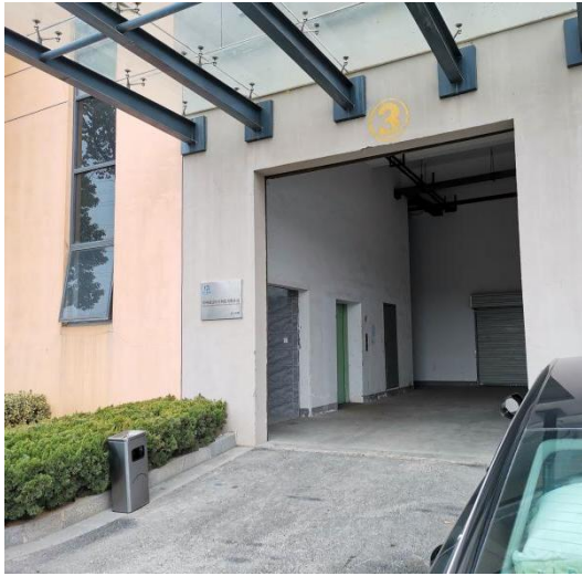
图 8-3 介入手术室拟建址南侧（逃生通道）
