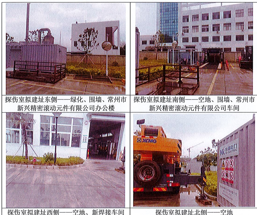
图 8-1 本项目探伤室拟建址周围环境现状照片
