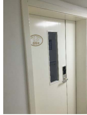
综合病房楼 DSA 机房 3 楼上备用产科病房
