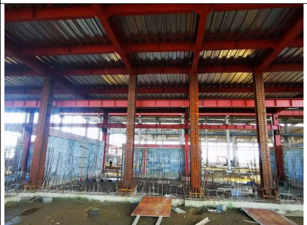
探伤房拟建址南面（机械设备存放间、机械设备间、生产车间区域，在建中）
