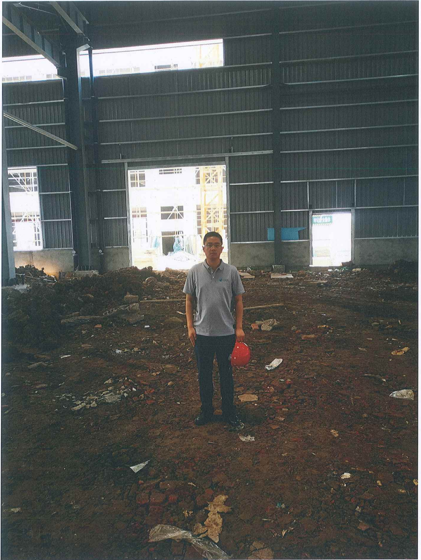
编制主持人在项目拟建址照片
