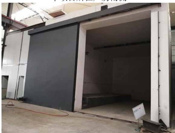
本项目探伤房
