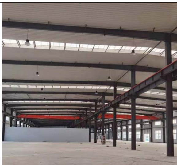
本项目探伤房西侧
