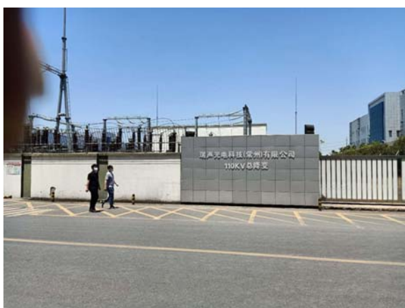
6F 生产大楼西侧变电站
