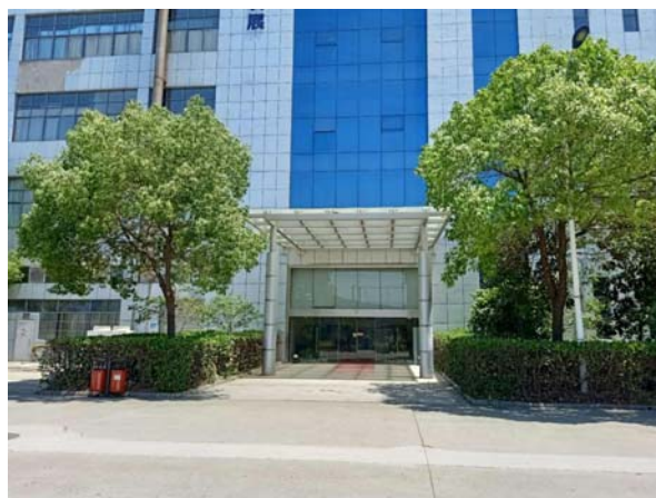
6F 生产大楼
