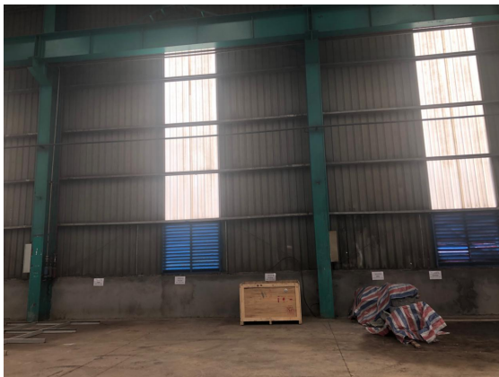
探伤铅房拟建址东侧
