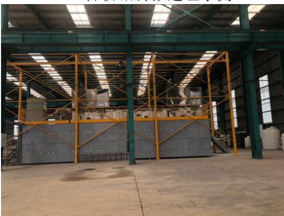
探伤铅房拟建址西侧
