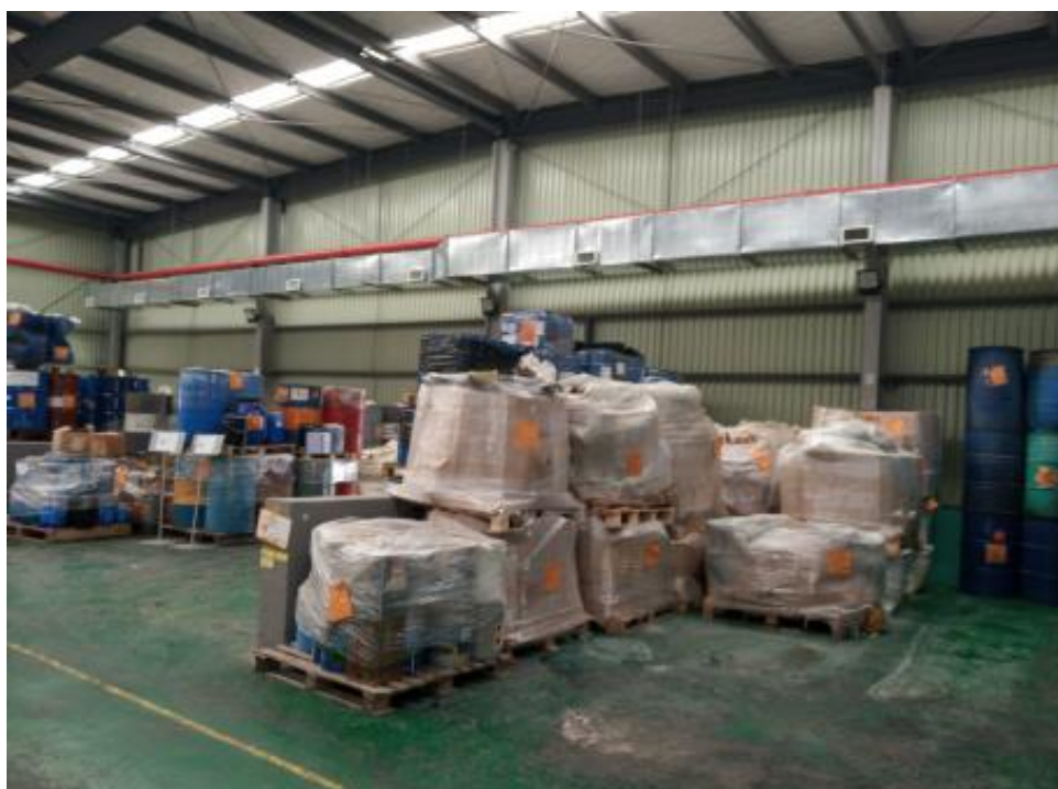
图 4-6 2 号仓库防治情况（废气收集系统）
