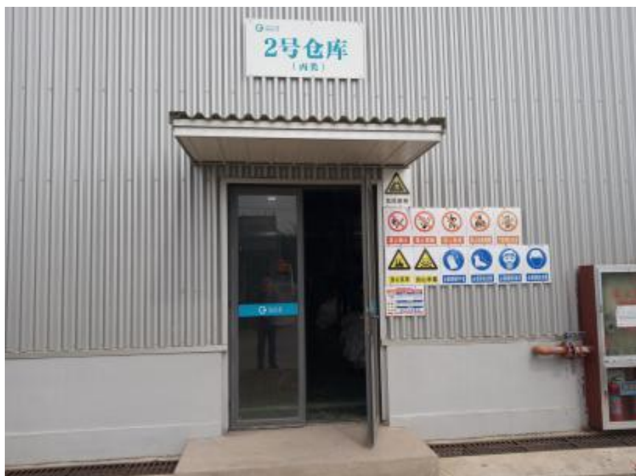
图 4-4 2 号仓库防治情况（丙类、标识、门禁）
