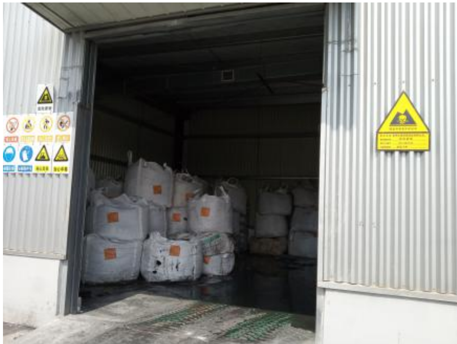
图 4-8 灰渣库防治情况（标识、门禁、防腐、废气收集、导流沟、集液槽）
