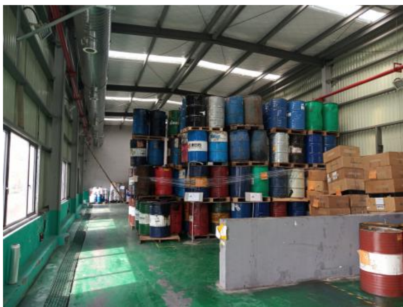
图 4-2 1 号仓库防治情况（导流沟、废气收集、地面防腐等）
