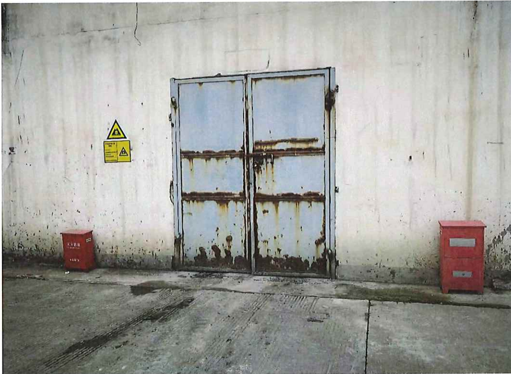
图 2 综合危废仓库门口警示标识
