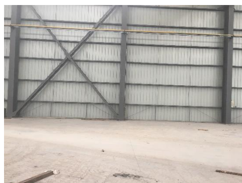
图 8-3 新建探伤铅房拟建场址南侧
