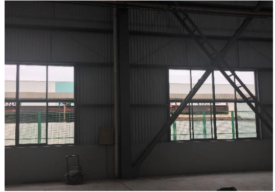
图 8-5 新建探伤铅房拟建场址北侧
