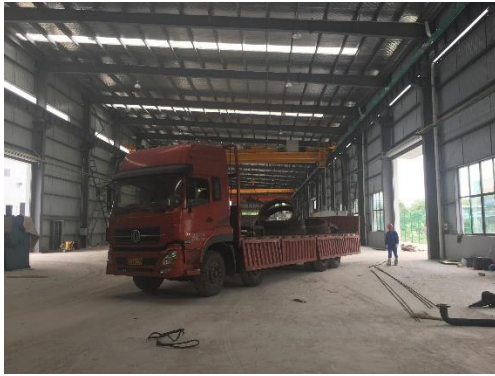
图 8-4 新建探伤铅房拟建场址西侧
