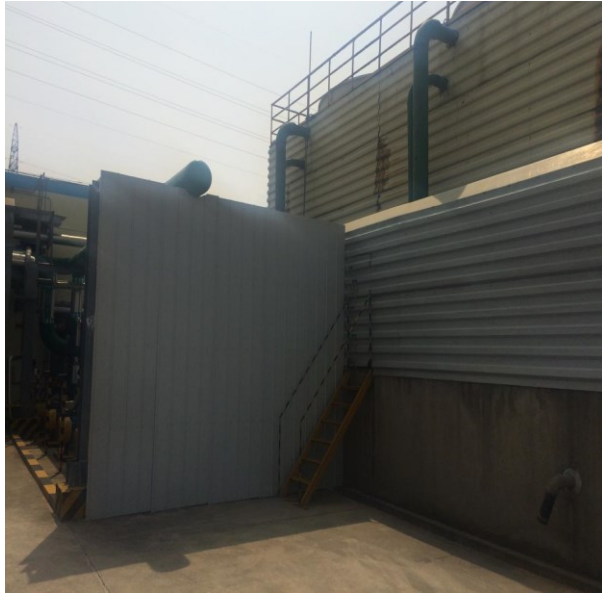
图 4-3 循环泵隔声墙
