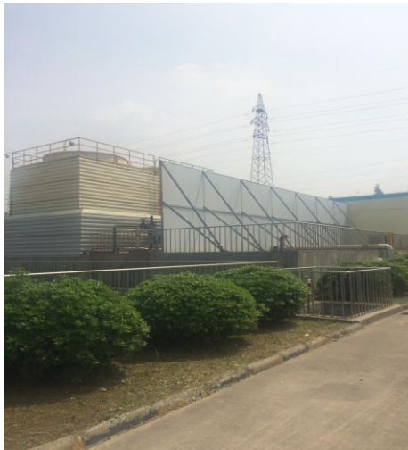
图4-1 冷却塔噪声隔声墙
