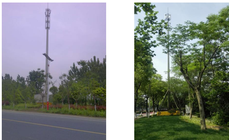
图 6-1 基站植被恢复照片
