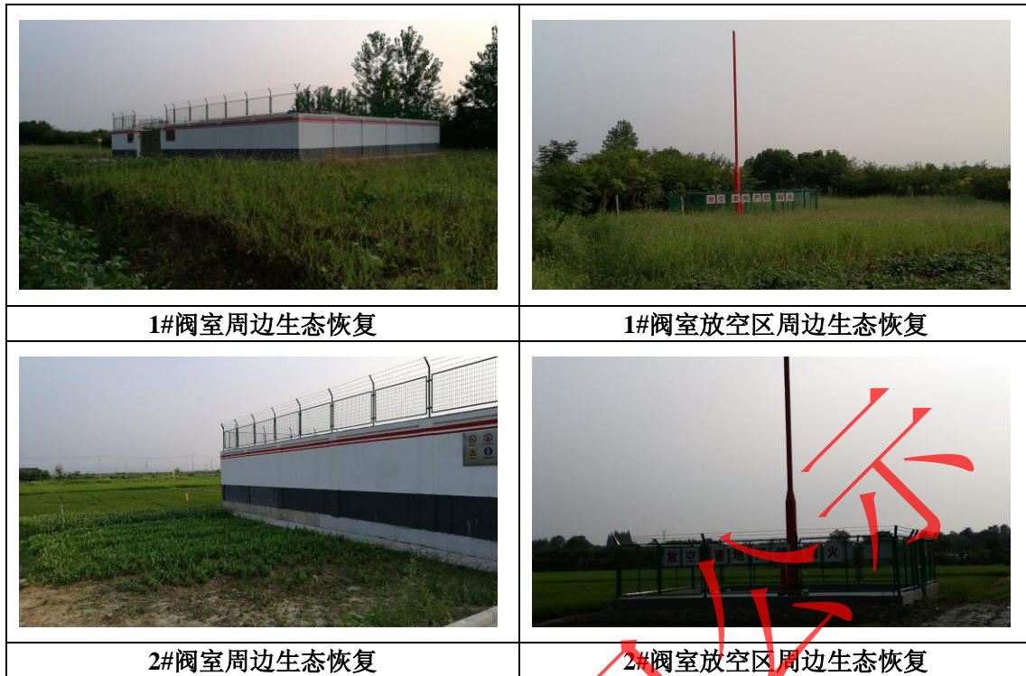
图 5-2-2 阀室周边生态恢复情况照片
