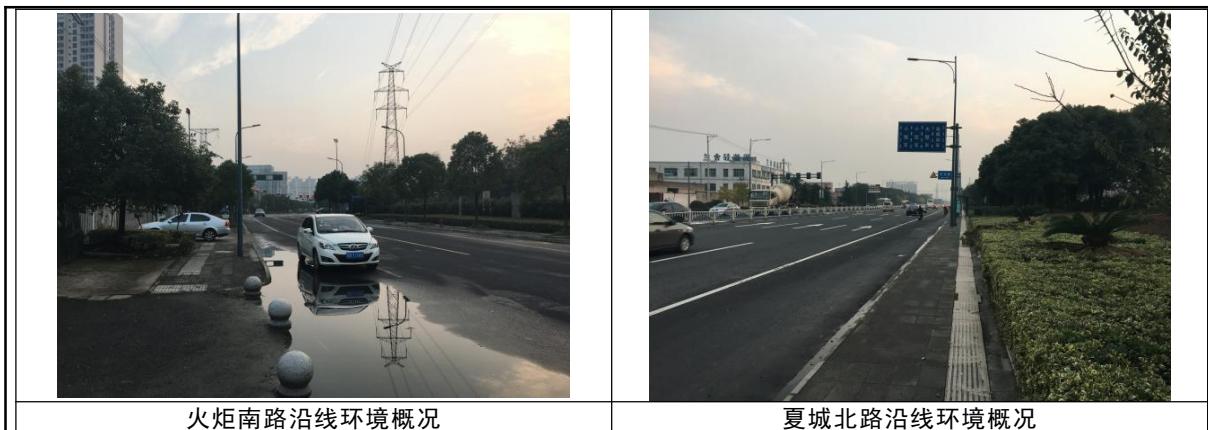
图 2-3 110kV 科教城北变电站进线工程沿线环境现状
