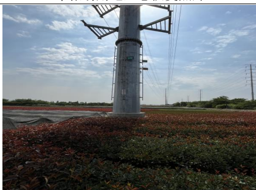
新建塔基处生态恢复照片
