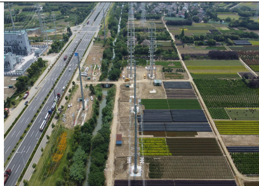
跨越场用地生态恢复照片
