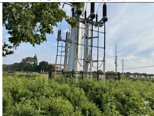
新建塔基处生态恢复照片
