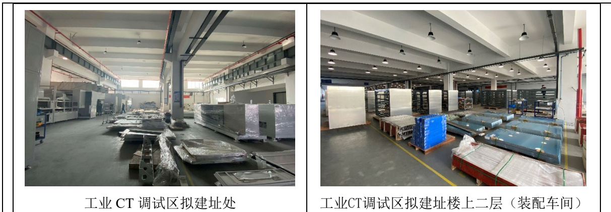
图 8-1 本项目工业 CT 调试区拟建址及周围环境现状照片
