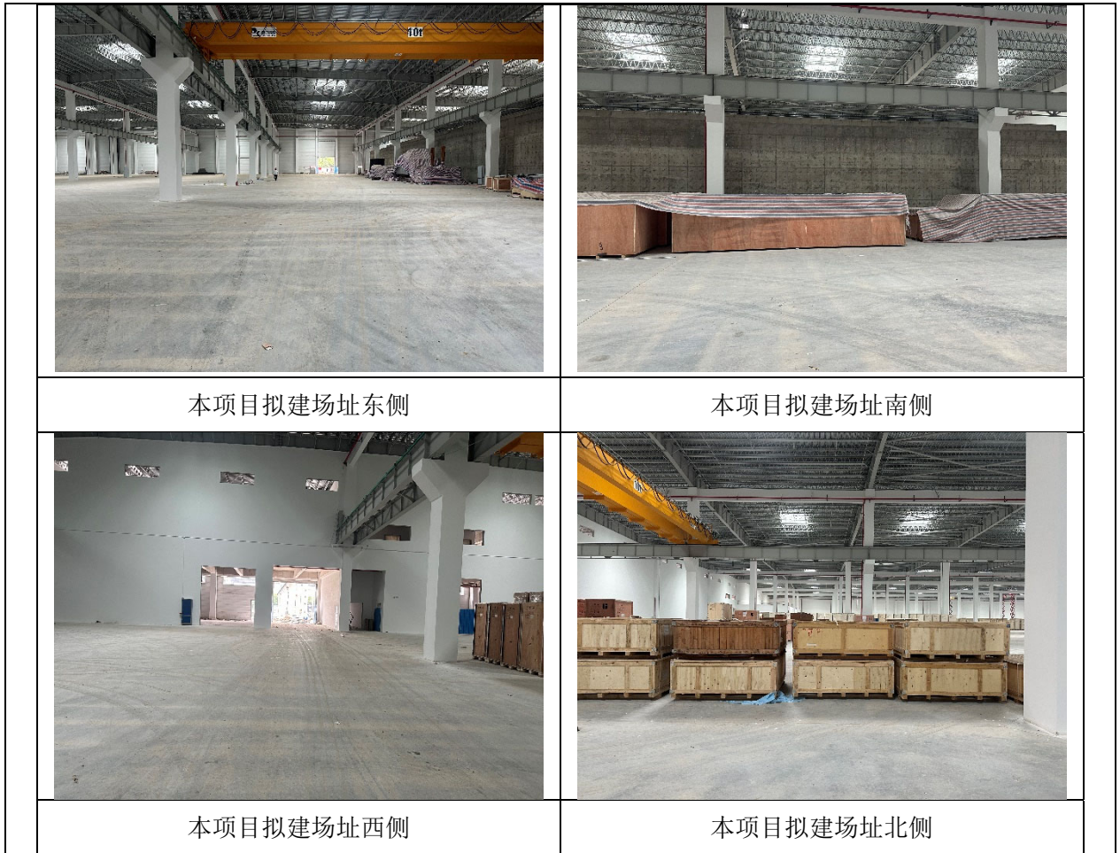
图 8-1 本项目拟建场址及周边环境现状图
