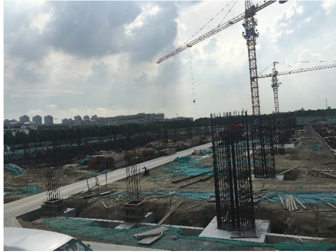
图 8-1 本项目加速器调试机房拟建场址
