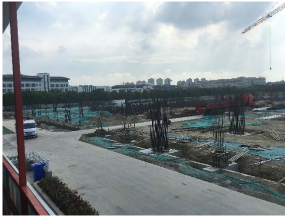
图 8-2 车间一南部建设情况
