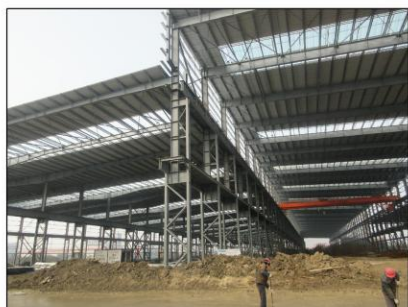
变电站北侧约29m处在建连轧车间
