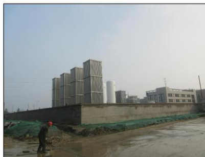
变电站东侧约28m处LNG液化天然气站
