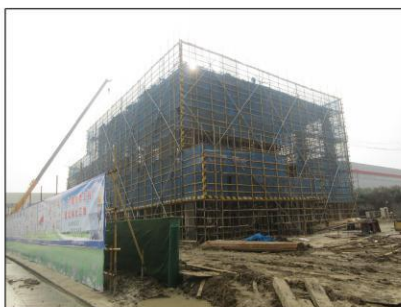
变电站站址现状
