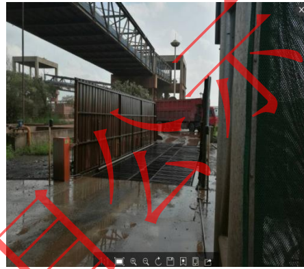
设备冲洗水池
