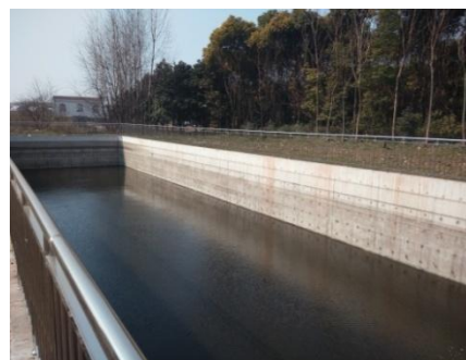
初期雨水扩建处理工程 2
