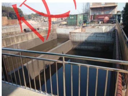
初期雨水扩建处理工程 1
