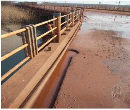
码头雨水收集管沟
