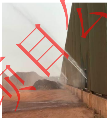
散货堆场喷淋系统
